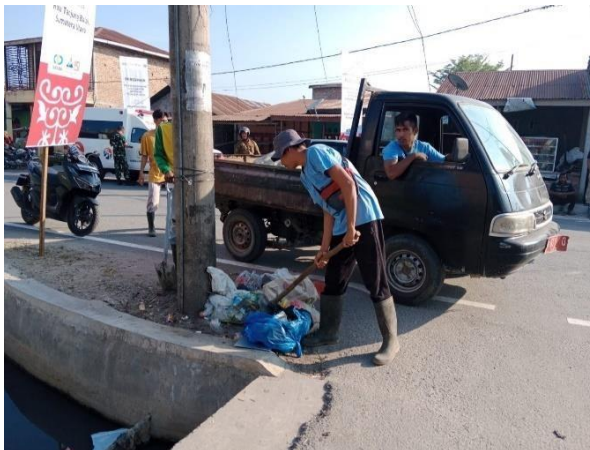
Pengorekan sampah dalam saluran drainase
